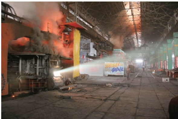
製鉄所内部の様子
