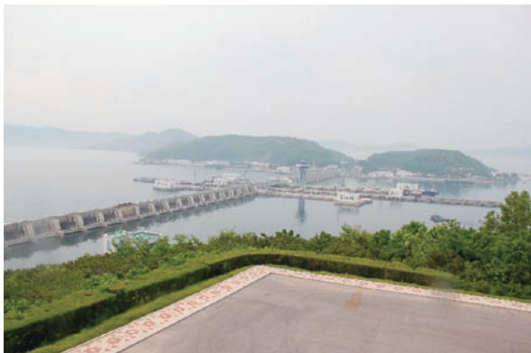
西海閘門の全景
